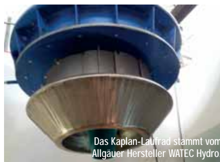
In Millimeterarbeit wird die Turbine-Generator-Einheit eingehoben und montiert.
