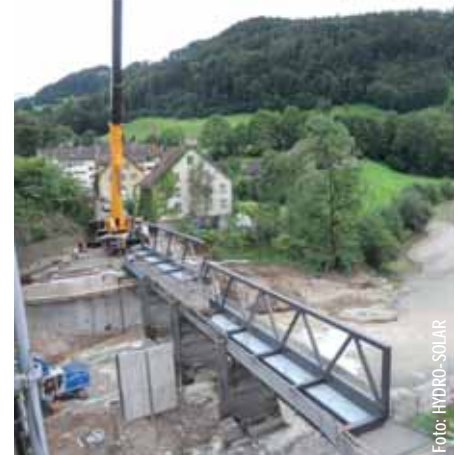
Montage der neuen Brücke über die Thur
