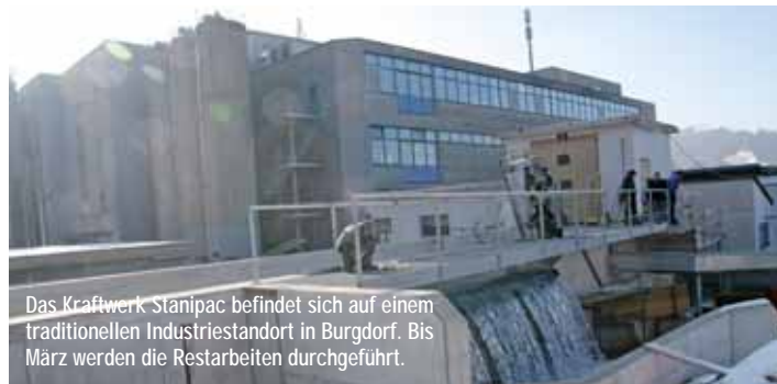
Auf einen Nenndurchfluss von 5 m 3 /s ist das neue Kraftwerk am Emmekanal ausgelegt.
